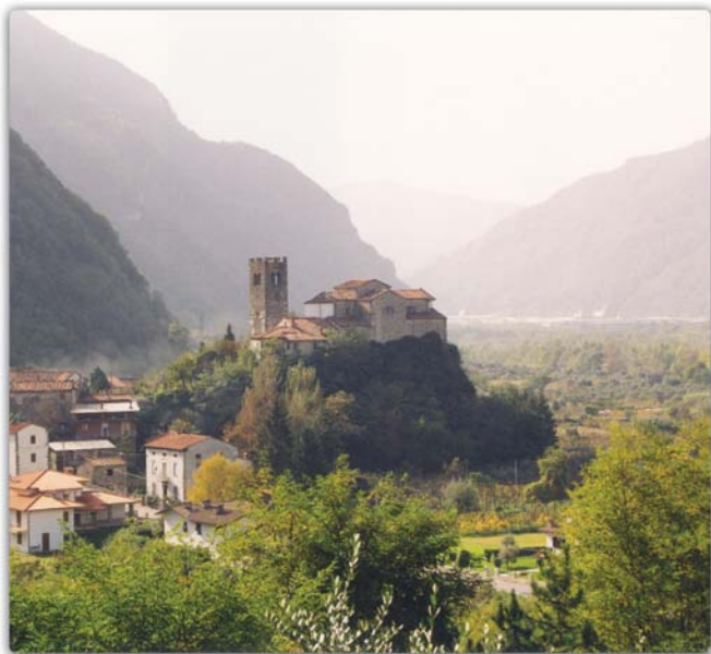
Anchiano (Borgo a Mozzano) I bunker sotto la Chiesa parrocchiale
